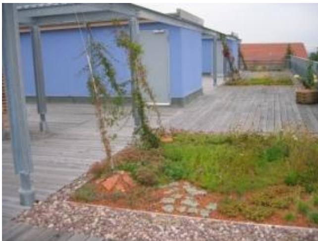
Abb. 3-2: Dachbegrünung mit Tonziegelsplitt [Foto: Mettke]
