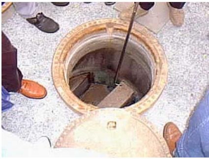
Abb. 2: Messung der Öl- und Schlammstärke von Leichtflüssigkeitsabscheidern (Quelle: Umweltzentrum des Handwerks Thüringen)
