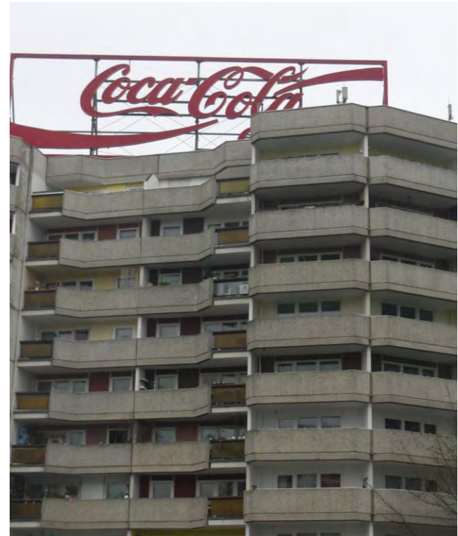
SBB-Seminar "Gebäude abfallarm sanieren und abbrechen"
