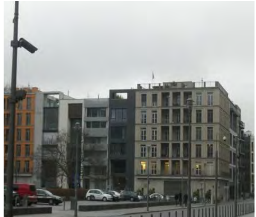
SBB-Seminar "Gebäude abfallarm sanieren und abbrechen"
