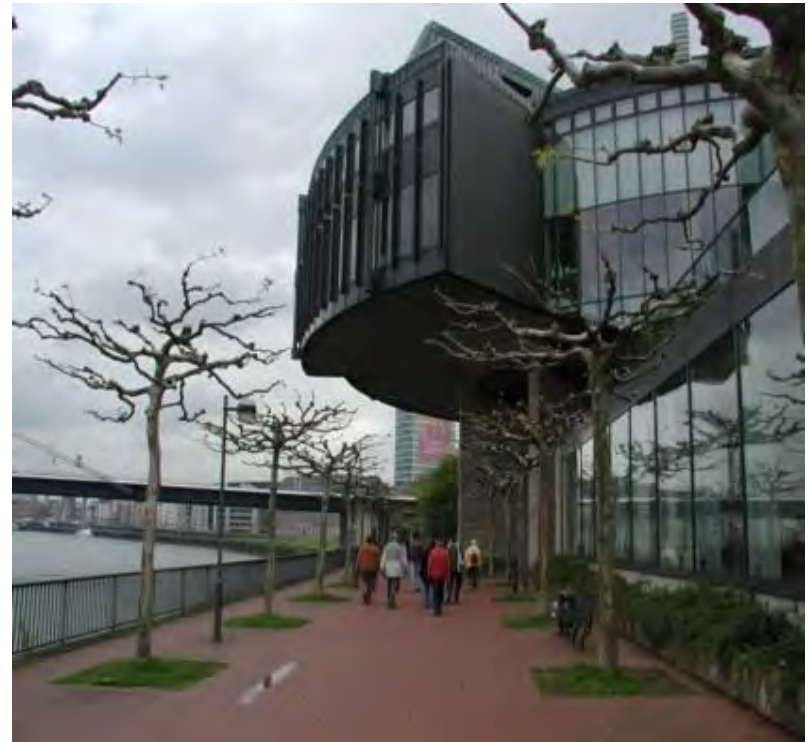
SBB-Seminar "Gebäude abfallarm sanieren und abbrechen"
