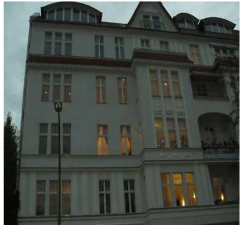
SBB-Seminar "Gebäude abfallarm sanieren und abbrechen"
