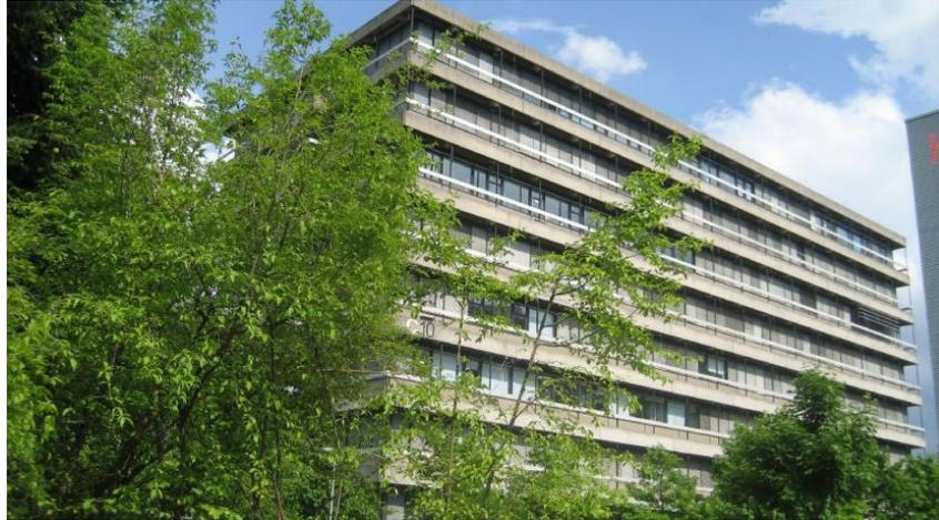
PCB-Inventar des Gebäudes (C-Bau Physik) vor Sanierung (2005): Mehr als **1 t PCB** in Fugenmassen, Wihelmi-Deckenplatten und Anstrichen verbaut.
